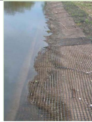
Berges disposant de fibre géo coco avant végétalisation
